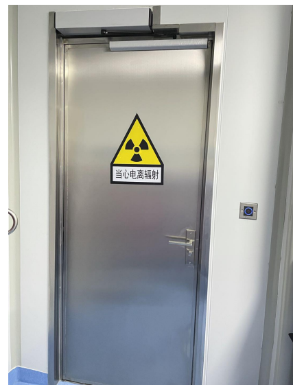
工作人员出入防护门
